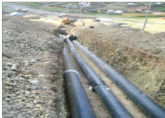
Зураг 3. Хүчитгэсэн хуванцар болон зөөлөн ширмэн хоолойнуудсуурилуулав. 2008он
