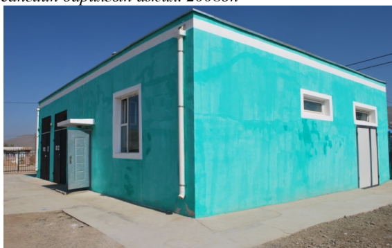
Зураг 6. Баянхошууны дээд насос станцын гадаад байдал. 2009он
