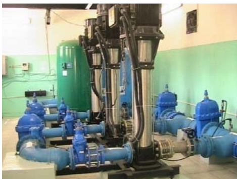
Зураг 25. Хайлаастын насос станцын 3 насосны хүчин чадлыг нэмэгдүүлэв. 2010он
