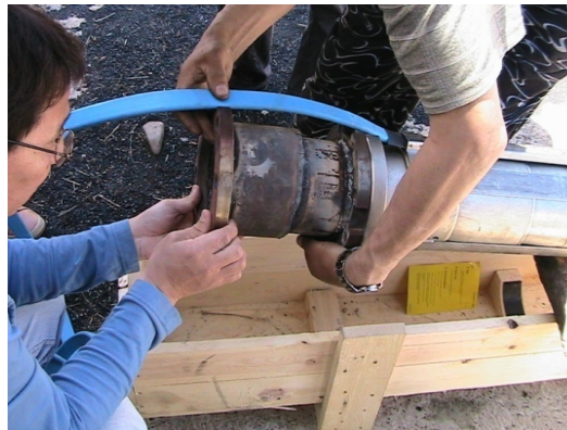
Зураг 24. Дээд эх үүсвэрийн гүний худгийн насосыг шинэчилж байгаа нь. 2010
