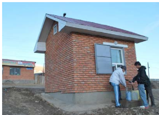
Зураг 9. Ус хангамжийн системд холбогдсон ус түгээх байр. 2009 он
